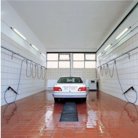
*Stationäre therm-Station mit Schlauchführung an den Seitenwänden.*
