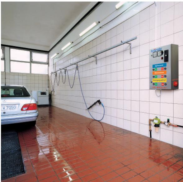
*Stationäre therm-Station mit Fernbedieneinheit und Schlauchführung an den Seitenwänden.*
